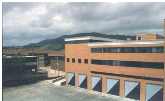
Edificio del Servicio de Extinción de Incendios
