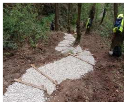
Peldaños acceso al lavadero Entrerregueros
